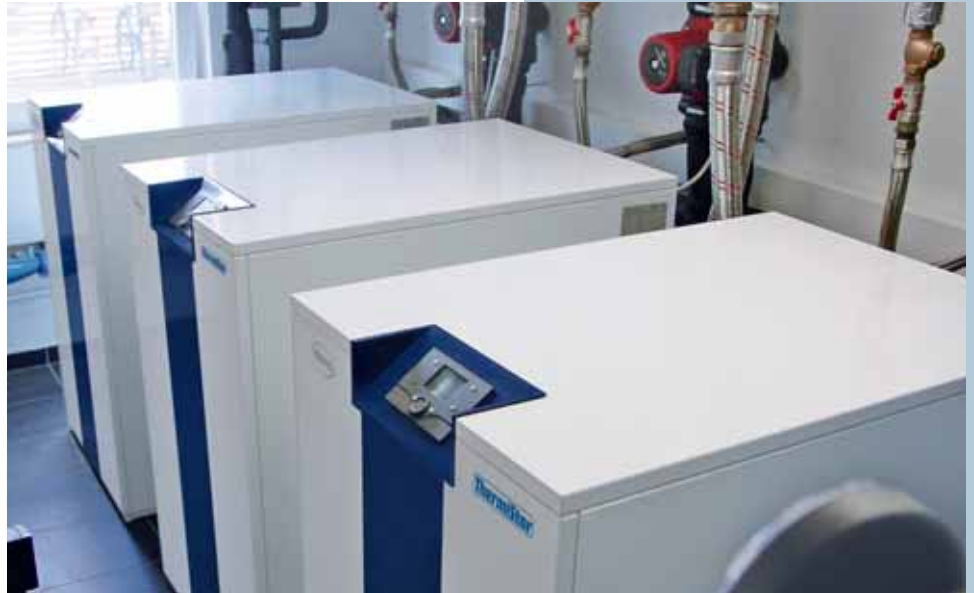
Die Kaskadenanlage mit drei ThermiStar Sole/Wasser-Wärmepumpen sorgt für Freude am Sparen.
