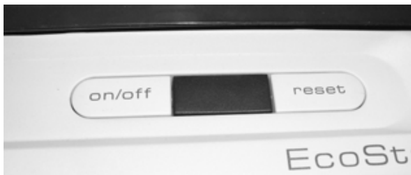
Abb. 5: Schalter on/off, Störleuchte und Taster reset am Kesselschaltfeld
